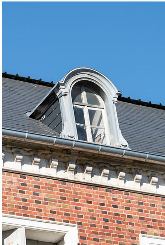
Façade de l'extension de Jules Guimard, lucarne.
