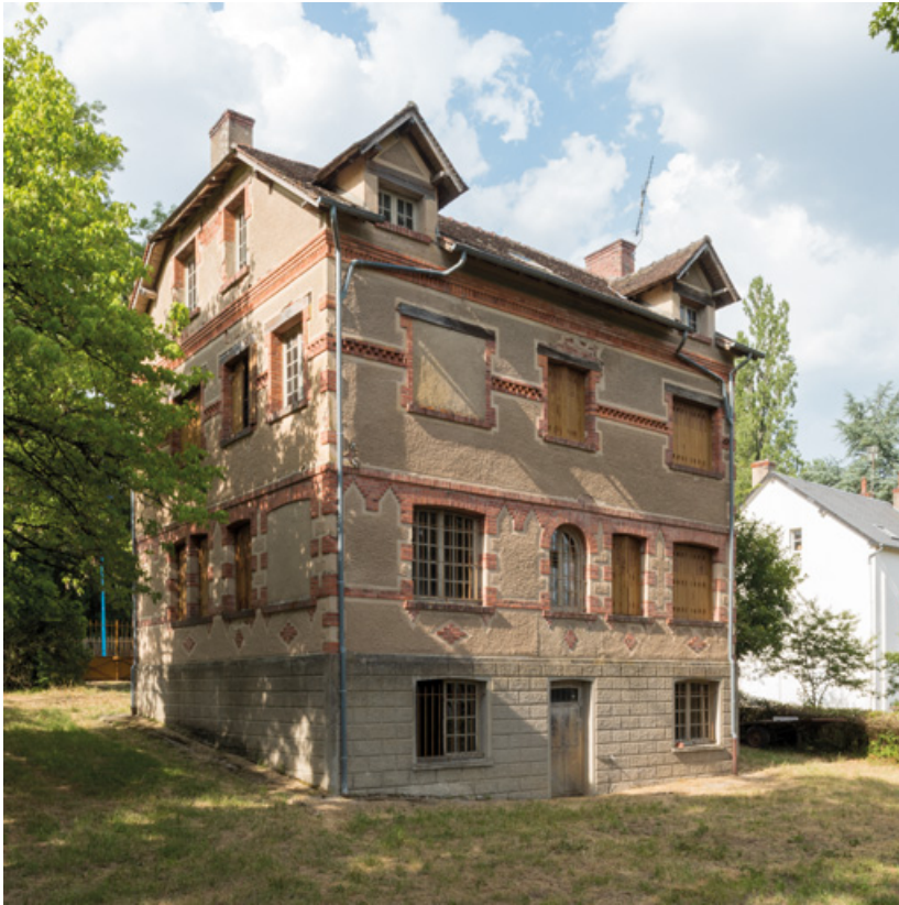
Façade postérieure, vue depuis le sud-ouest.
