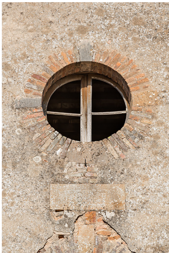
Oculus du troisième niveau.
