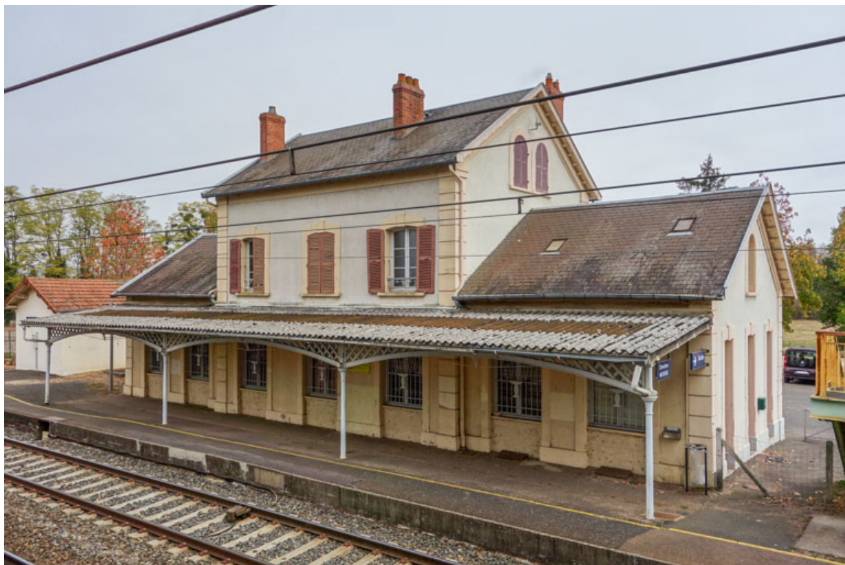
Façade, côté voie ferrée.
