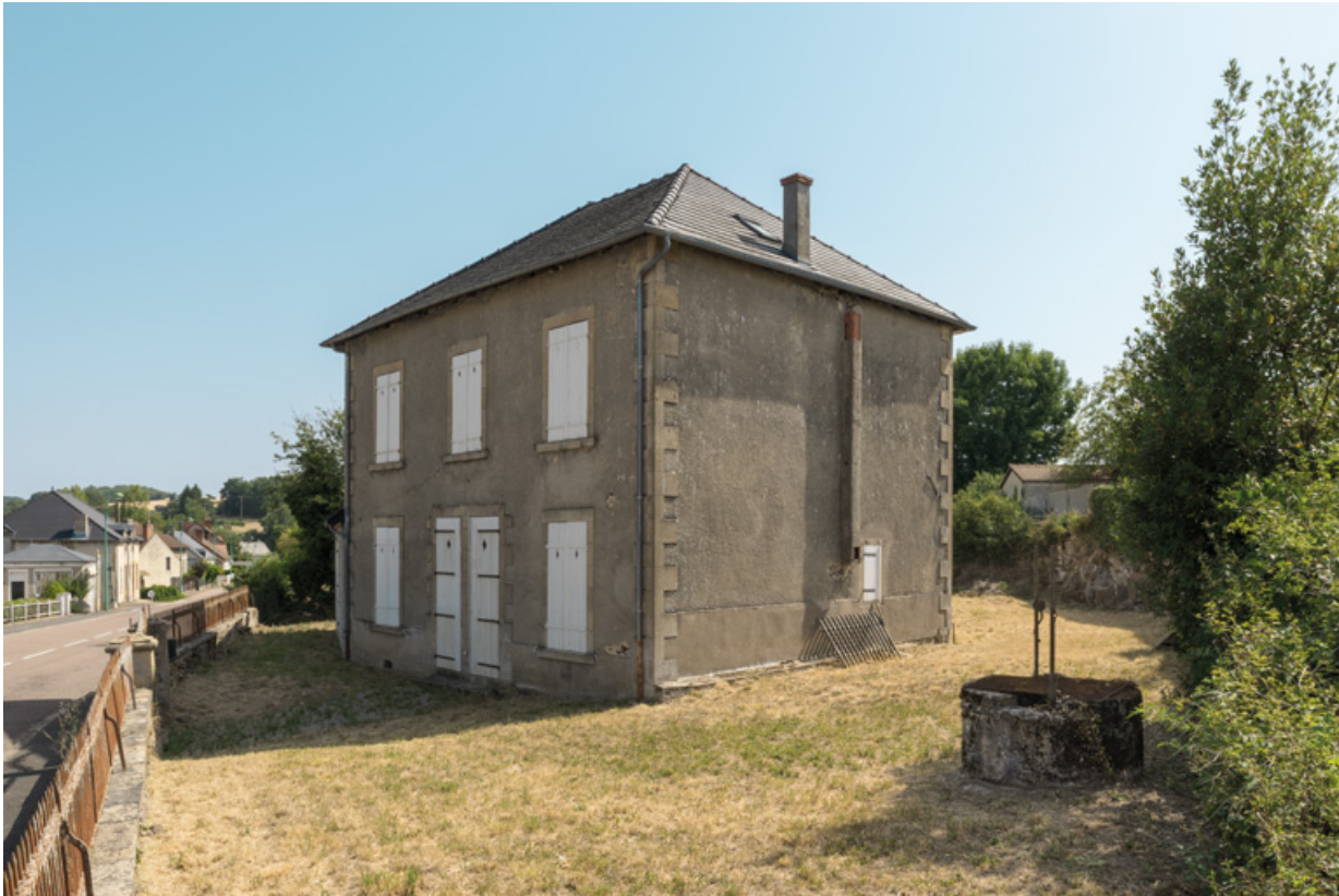
Façade principale, vue depuis le sud-ouest.
