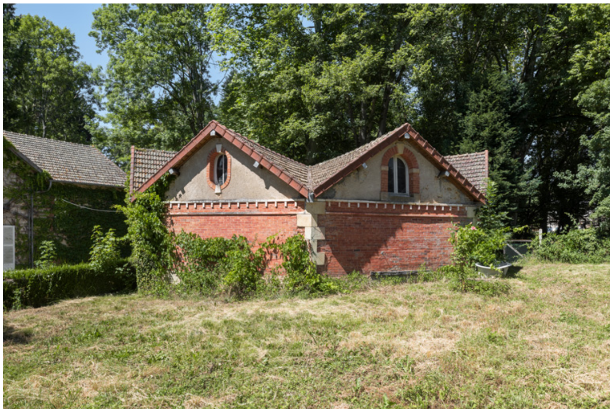
Vue depuis le sud-sud-est.
