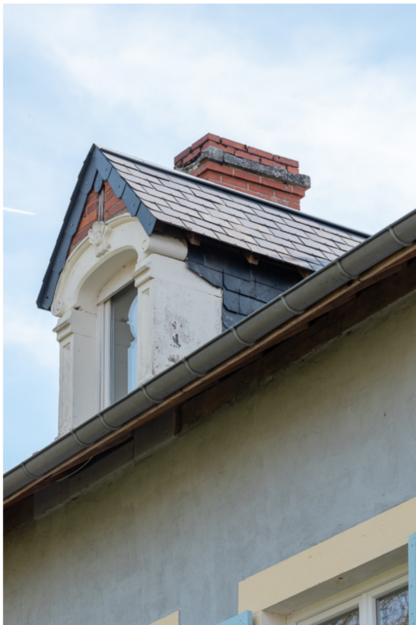
Lucarne de la façade nord-ouest.
