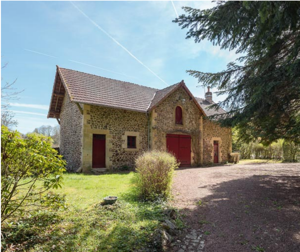
Façade principale donnant sur la villa.
