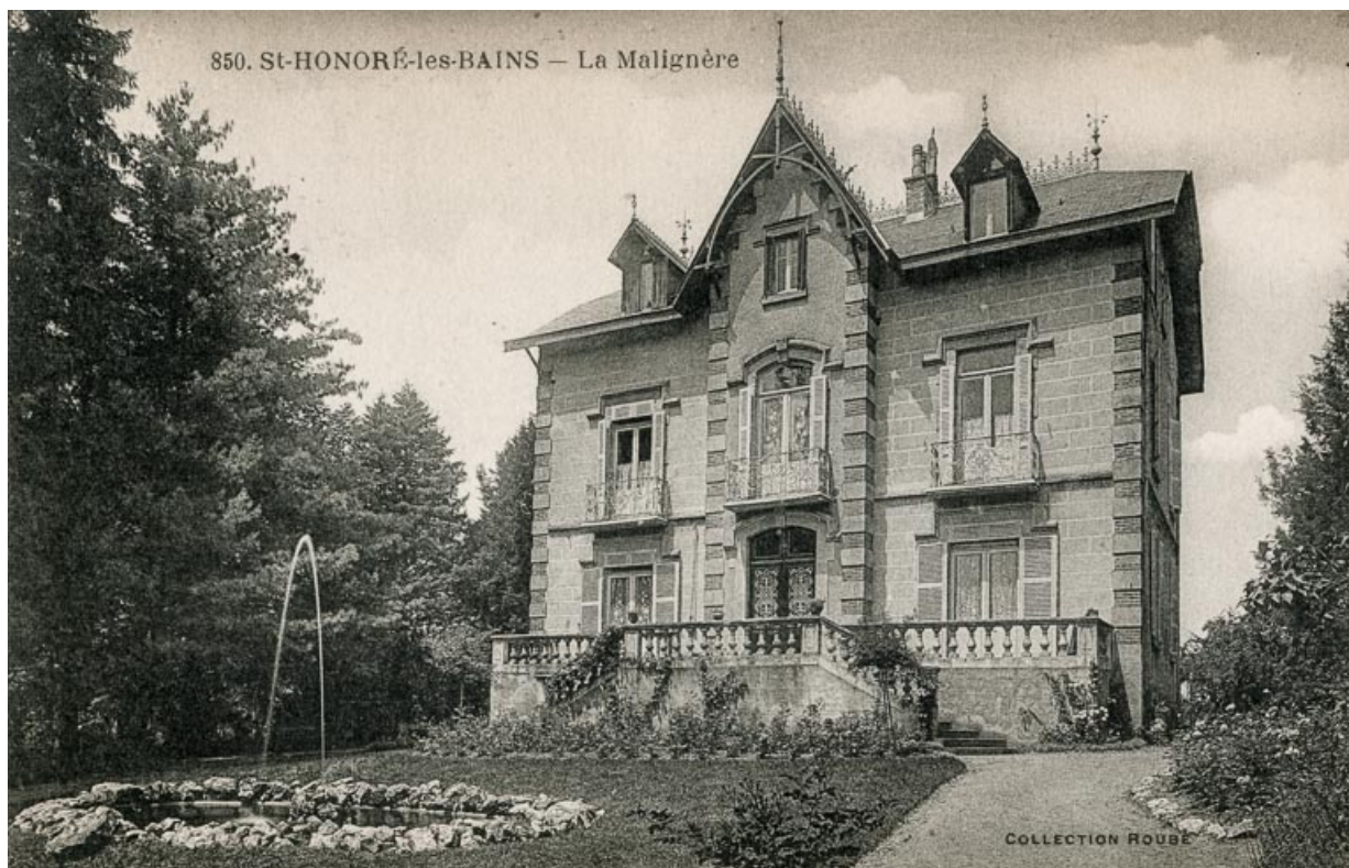
Façade principale de la villa.
