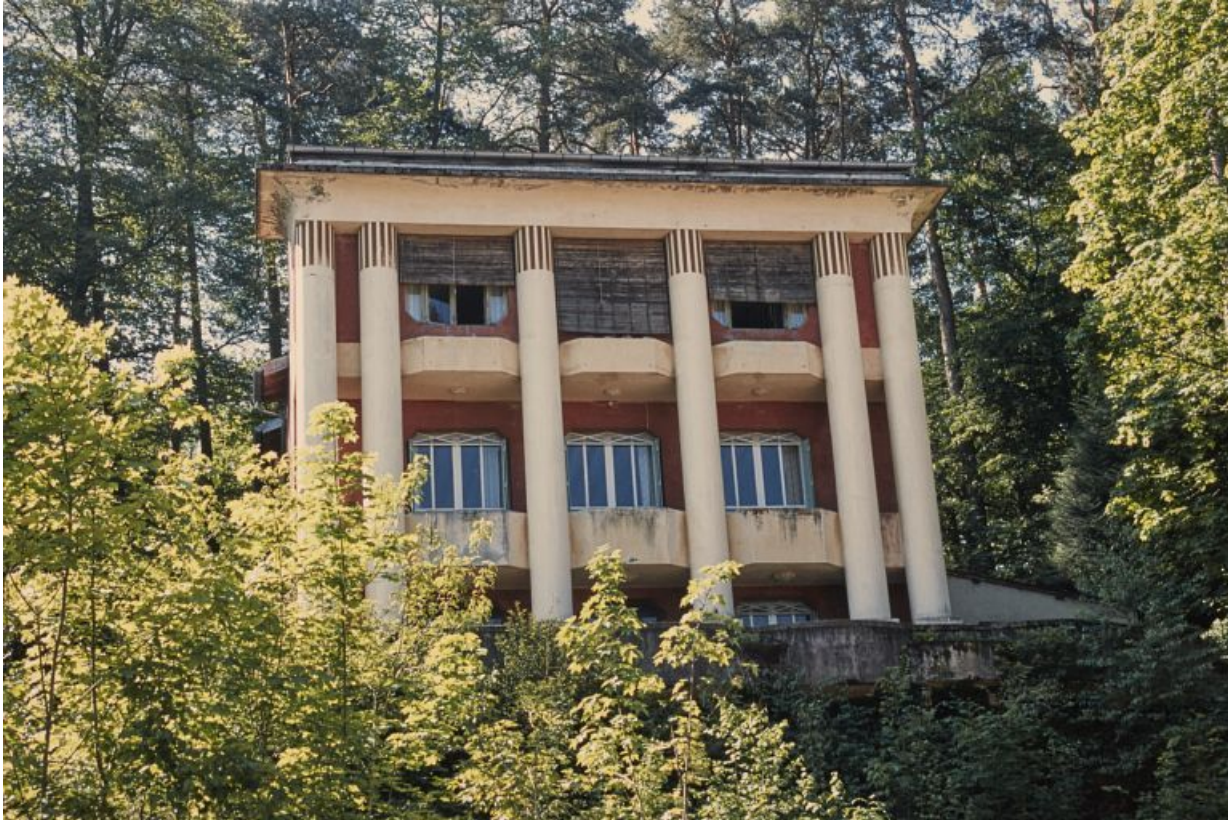
Façade nord, vue de face.
