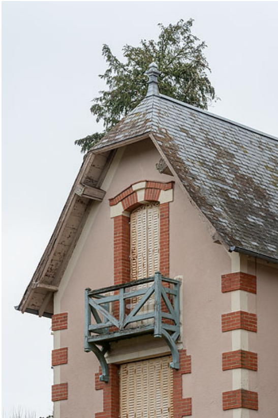
Mur-pignon en façade, demi-croupe en ardoise.
