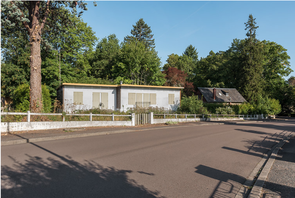
Vue depuis le sud-est.
