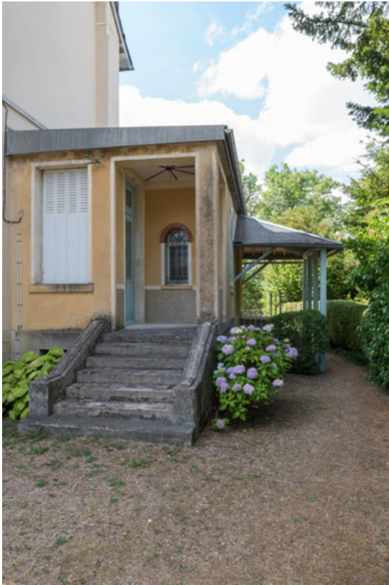
Entrée latérale, côté nord.
