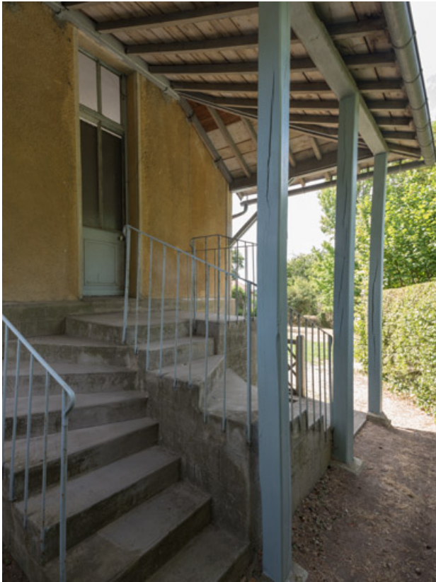
Entrée latérale, côté nord.
