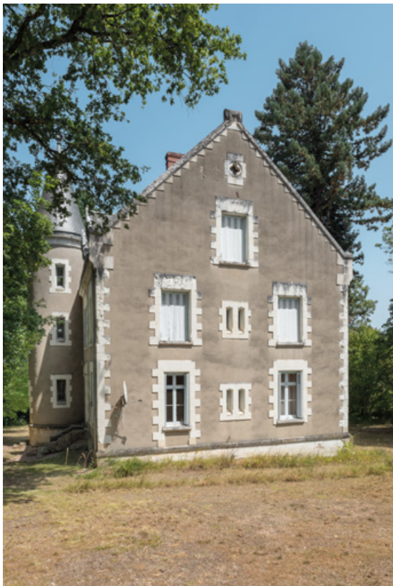
Mur pignon sud-ouest.
