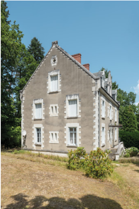
Mur pignon sud-ouest.
