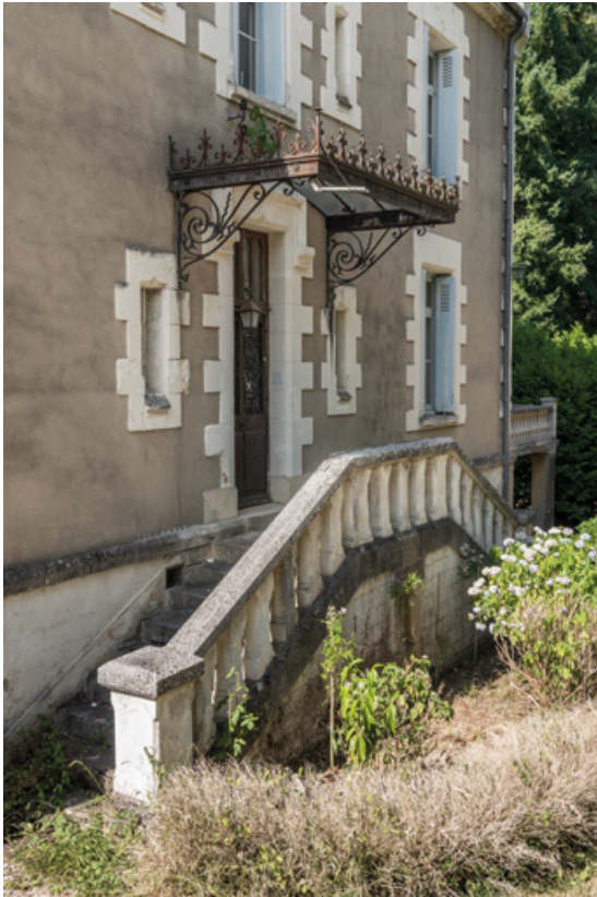
Perron de la façade sud-est.
