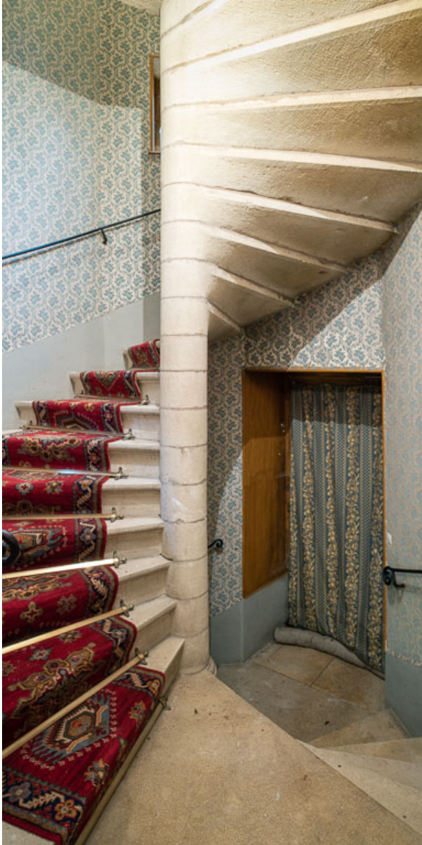
Escalier de l'entrée sud-ouest.
