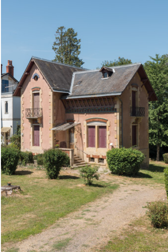
Façade sur l'avenue de Rémyilly.
