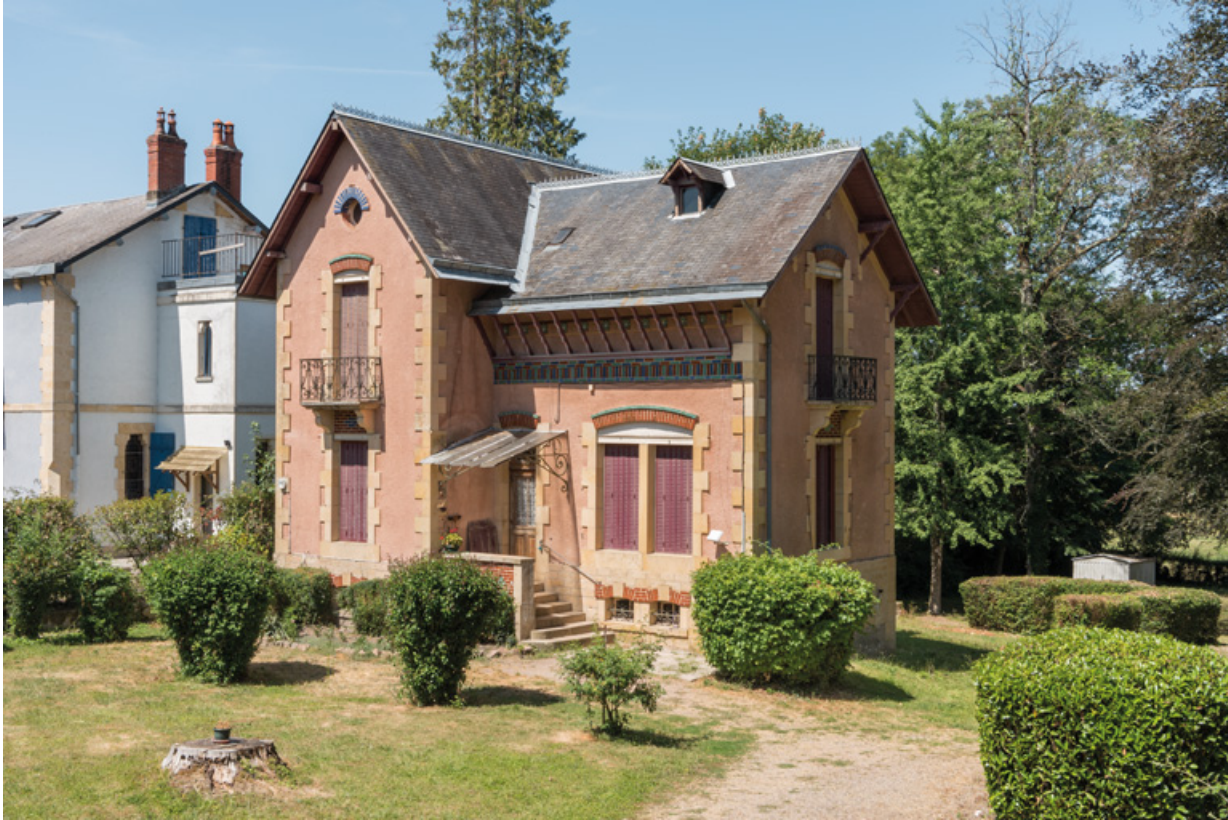
Façade sur l'avenue de Rémyilly.
