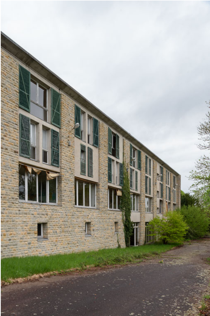
Élévation extérieure du corps de bâtiment principal.
