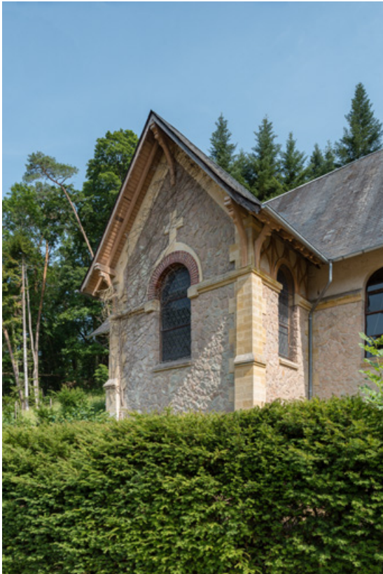
Façade du bras gauche du transept.
