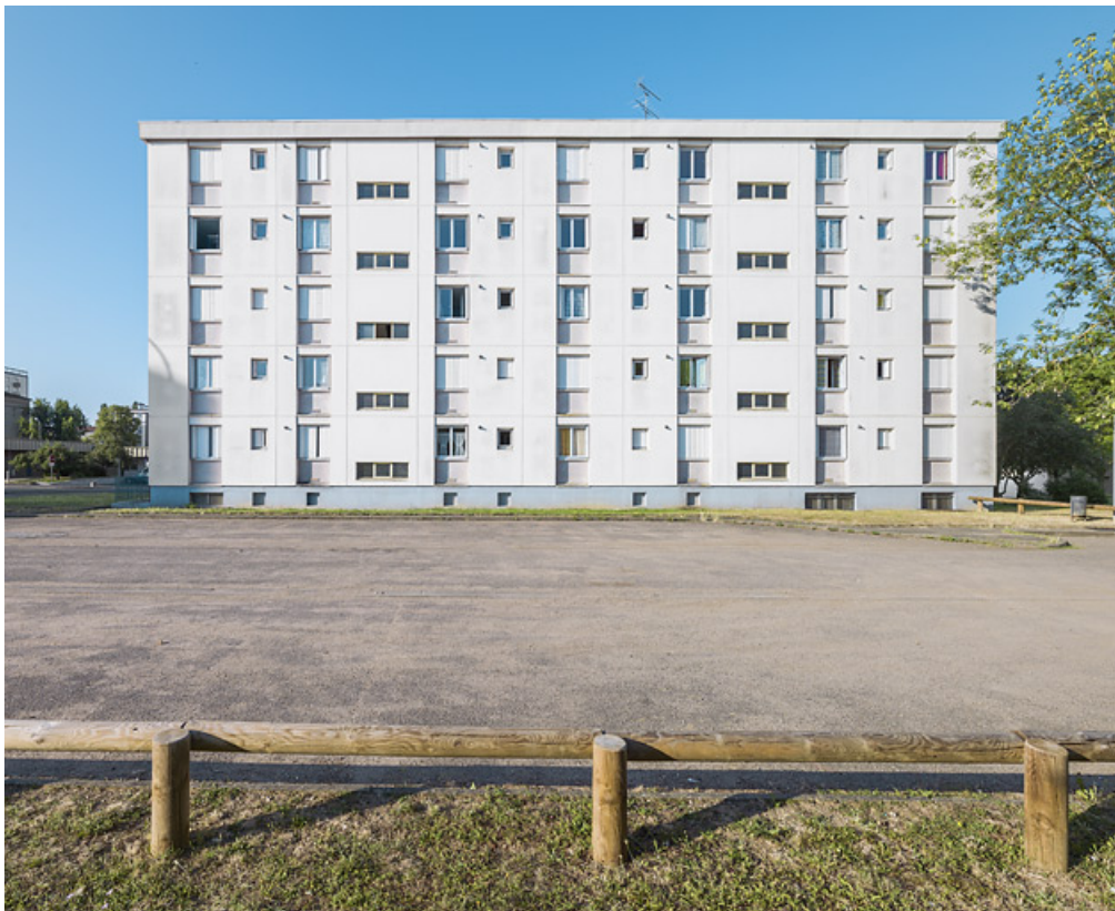
Bâtiment B-1, façade postérieure nord.
