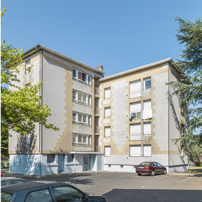
Bâtiment Million-2, façade antérieure nord-est.
