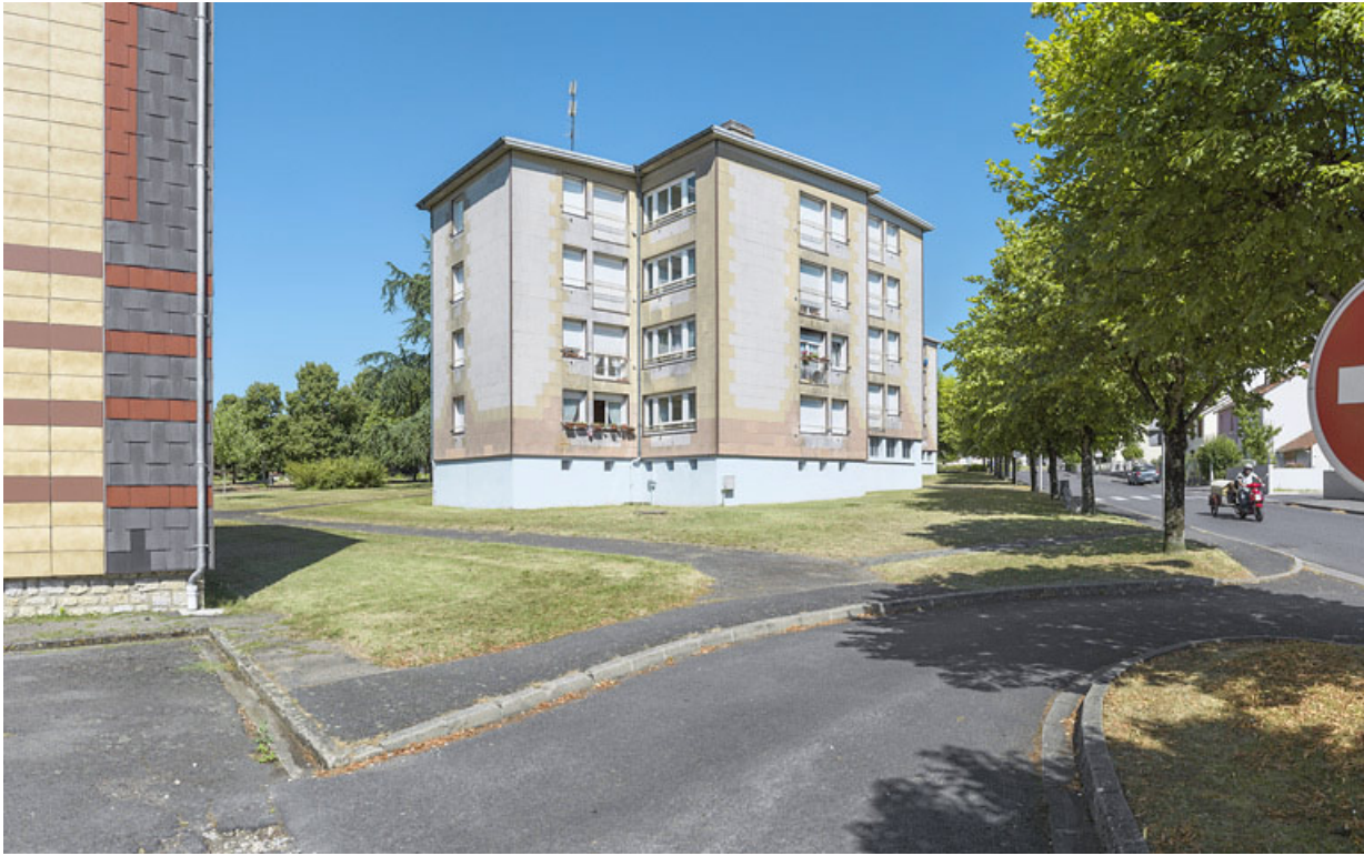
Bâtiment Million-1, façade postérieure sud.
