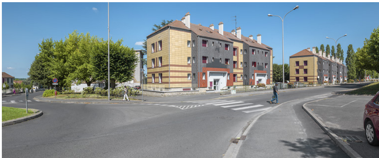
Bâtiments Binot-D et Binot-E, façades antérieures est.
