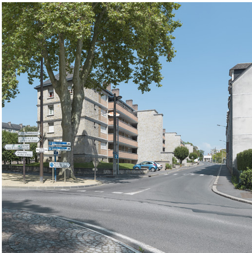
Bâtiment D : façades antérieure et latérale sud.
