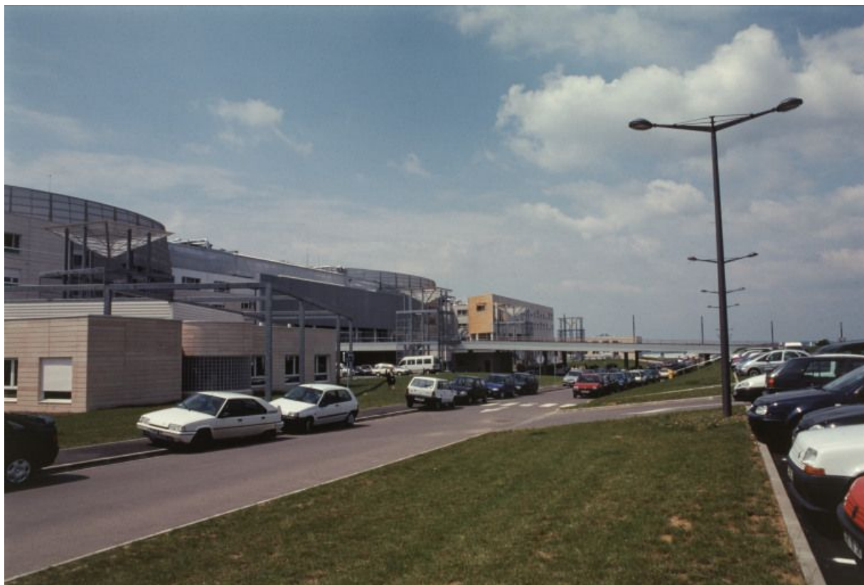
Façade antérieure, vue d'ensemble.
