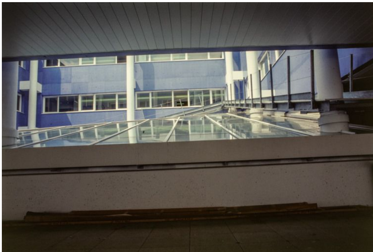
Vue du patio vers les salles d'opération.
