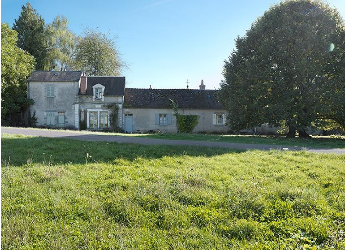
Vue d'ensemble des bâtiments, de face.
