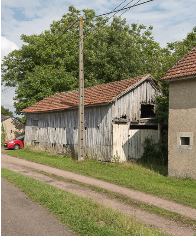
Vue de l'extension de la maison éclusière.
