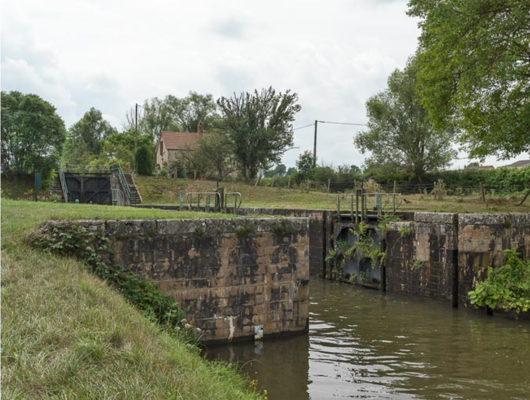
Le second sas, vu d'aval.
