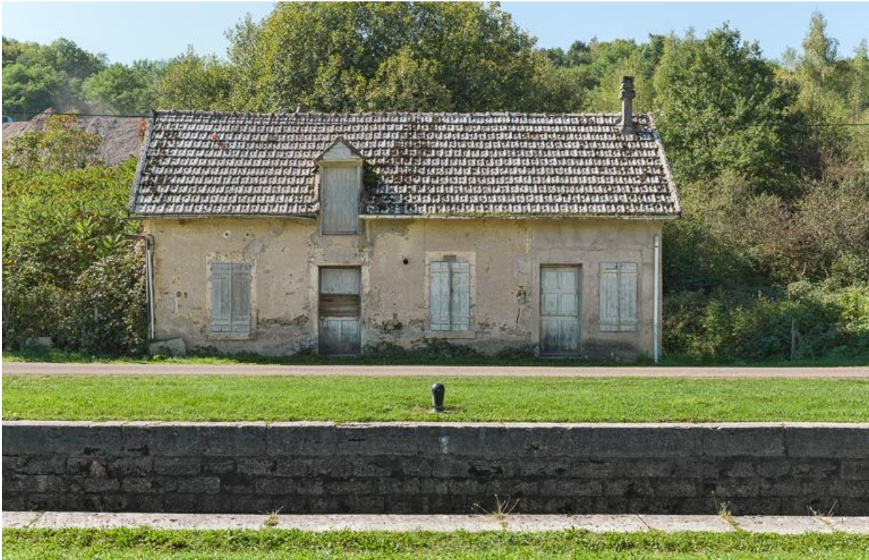
Vue de face de la maison éclusière.
