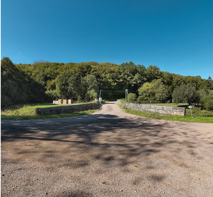
Vue d'ensemble du pont, avec les parapets.
