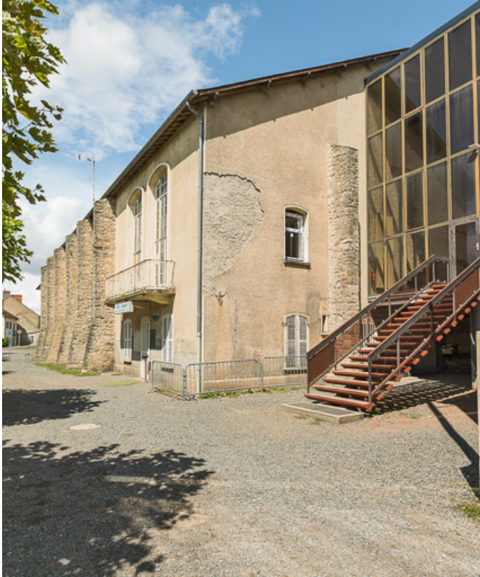
Vue du bâtiment et des contreforts.
