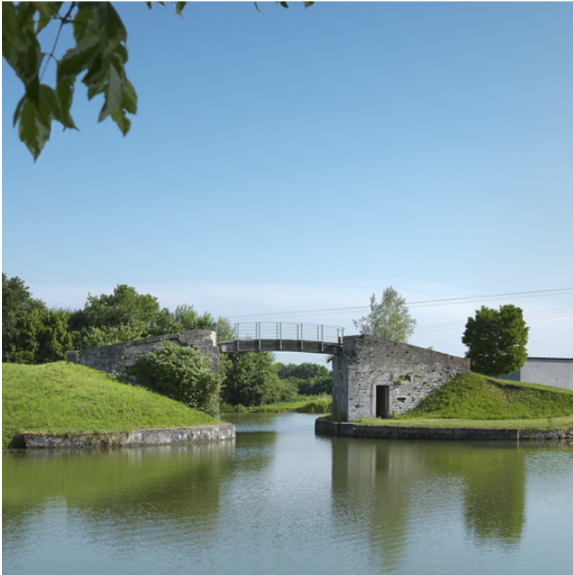
Vue de la passerelle haute, de face.
