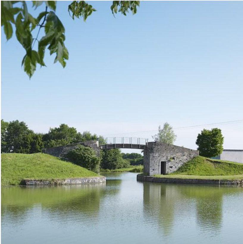
Vue de la passerelle haute, de face.
