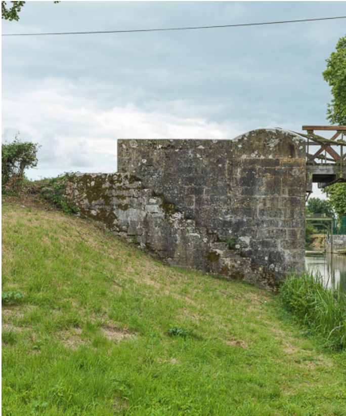
Détail d'une culée en moellons.
