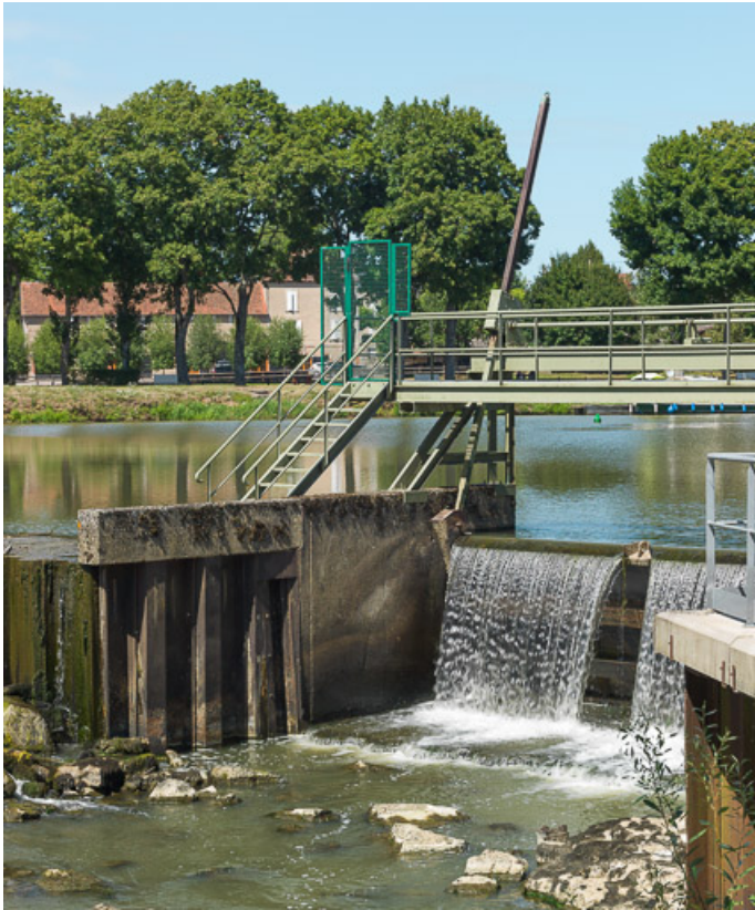
Vue du déversoir.
