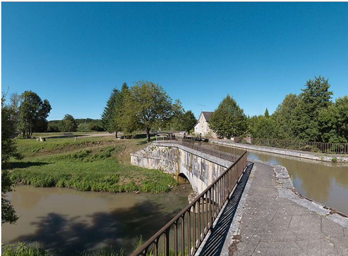
Vue d'ensemble du pont canal.
