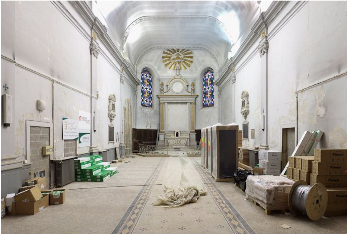
Vue intérieure de l'ancienne chapelle.
