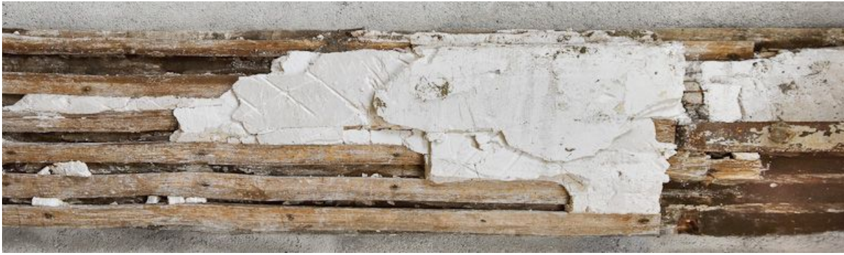
Détail de mise en oeuvre : lattis.
