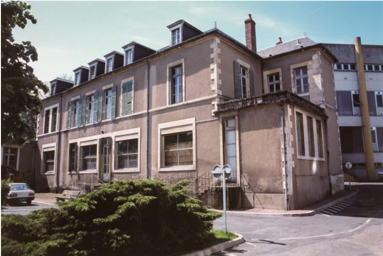
Bâtiment de biologie, façade postérieure. 58, Nevers Colbert
