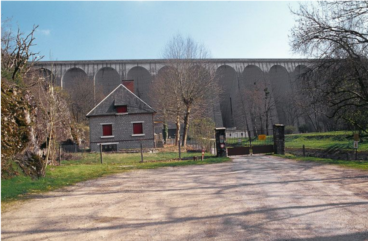
Vue aval du barrage.
