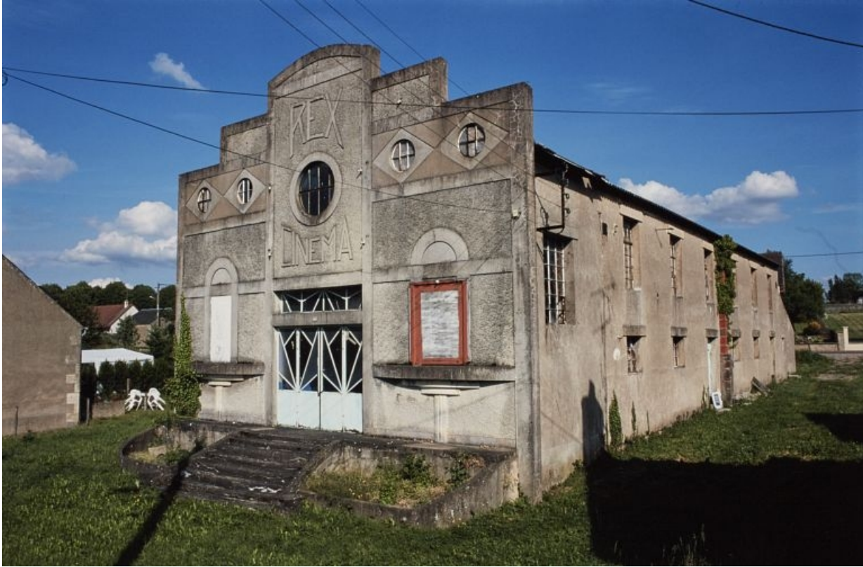
Elévation principale et latérale droite (en 2000), vue de trois-quarts. 58, Guérigny, 13 rue Masson
