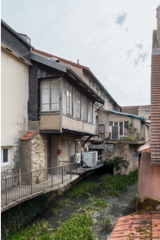
Façade latérale gauche, depuis l'ouest : cinéma.
