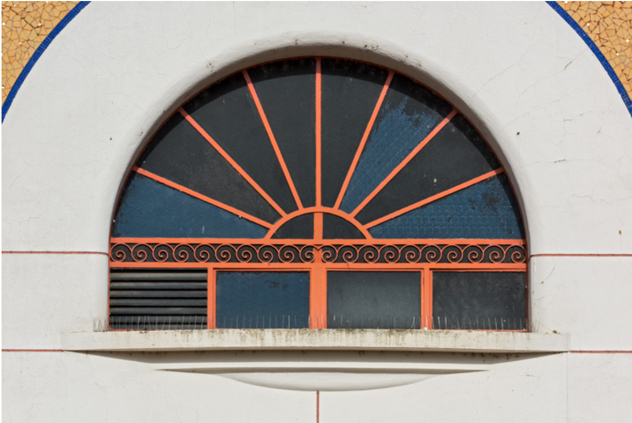
Façade antérieure, partie haute : baie.
