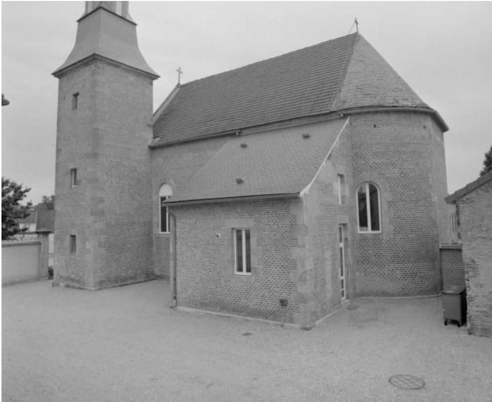
Vue d'ensemble du bâtiment, façade latérale droite.
