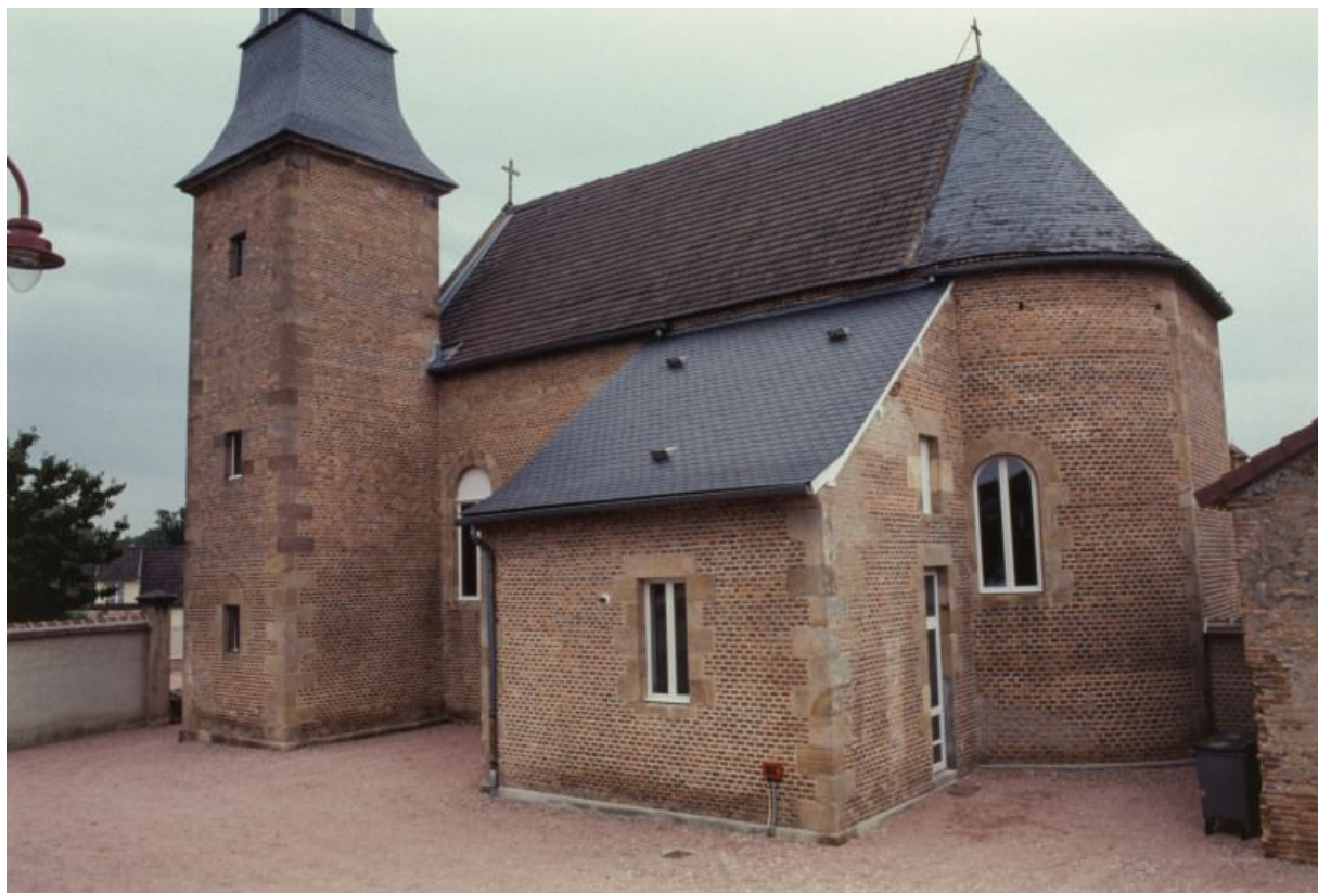
Vue d'ensemble du bâtiment, façade latérale droite.
