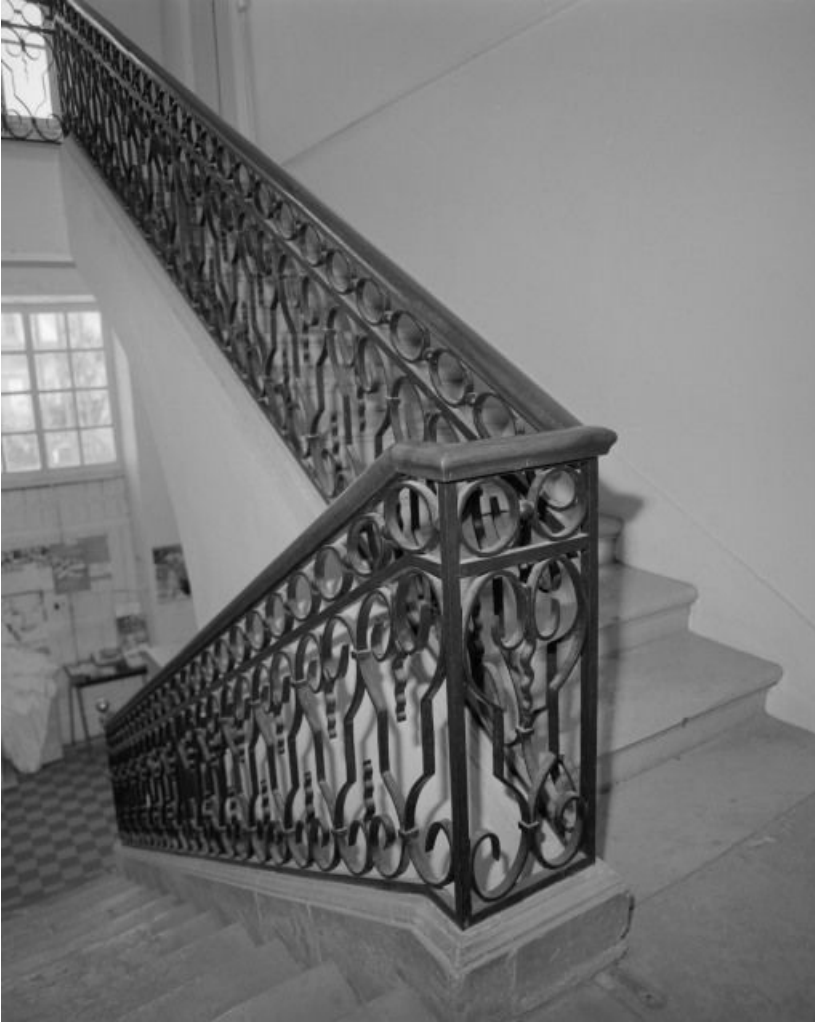
Vue d'ensemble de l'escalier.
