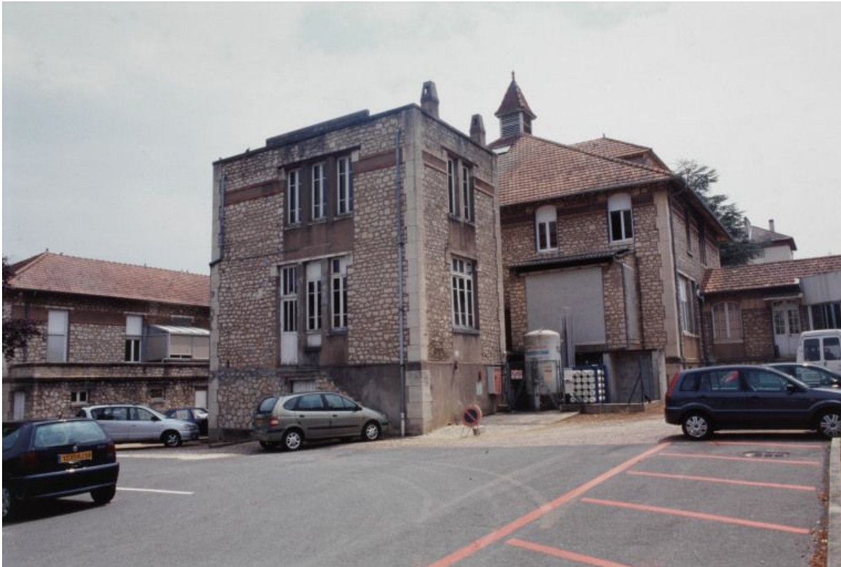
Vue d'ensemble du bâtiment principal, façade postérieure.
