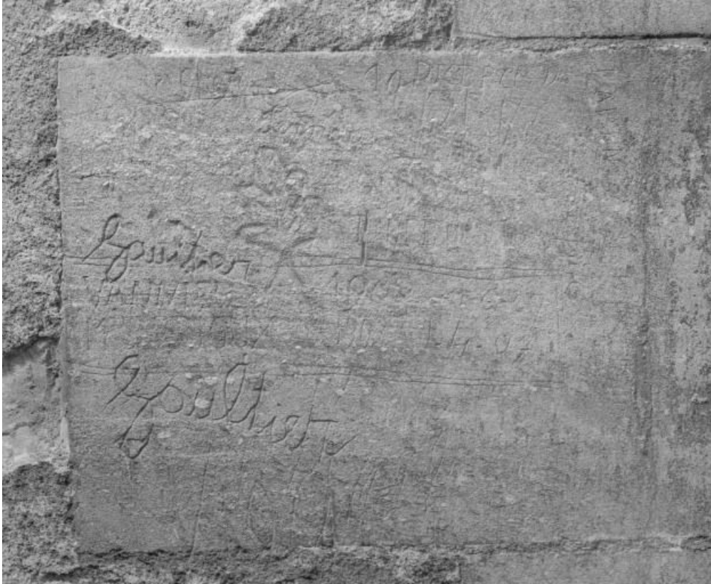
Graffitis sur l'aile militaire du bâtiment principal.
