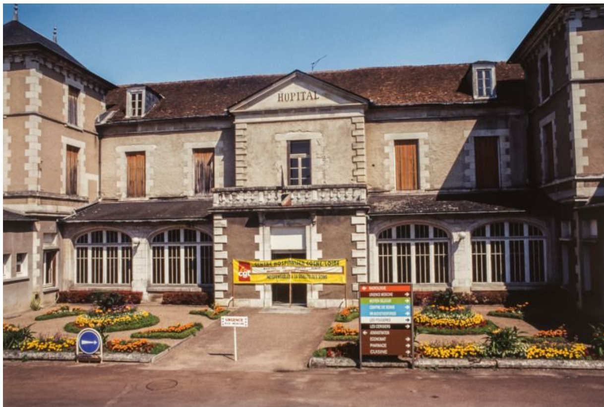
Bâtiment principal, façade antérieure.
