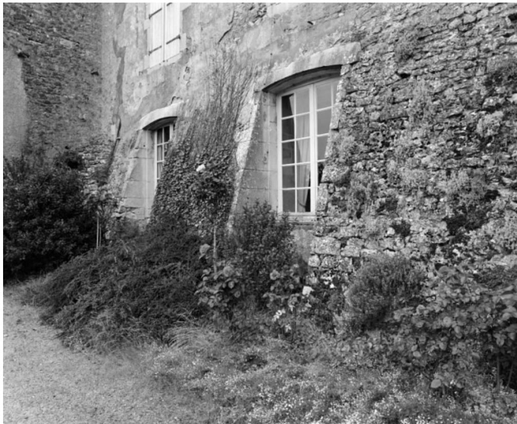
Bâtiment sud-ouest. Elévation antérieure, détail.
