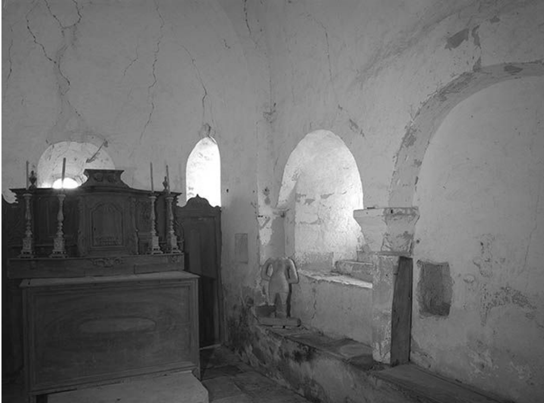
Mur droit du chœur.
