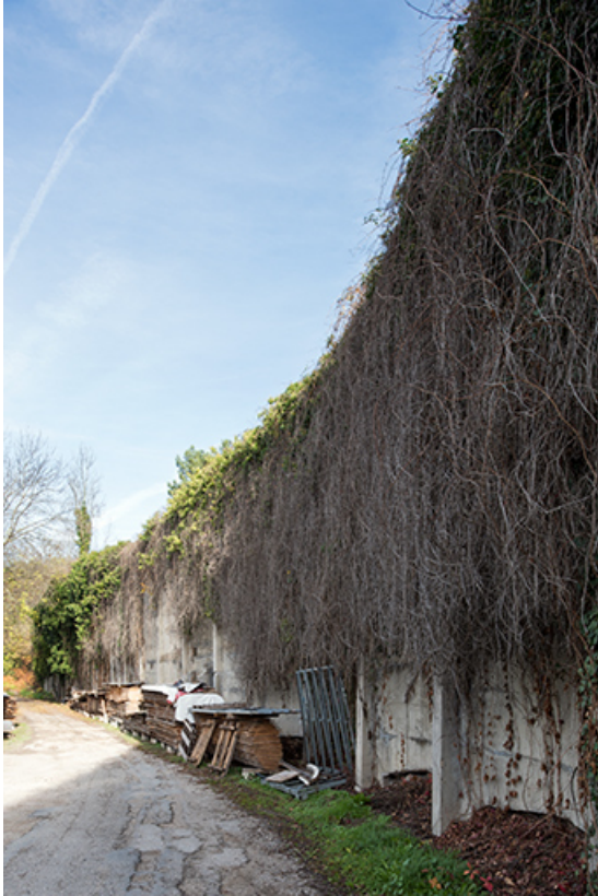
Mur de soutènement, depuis le sud.
