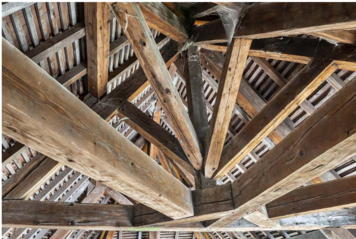
Charpente. Détail de l'enrayure sud.
