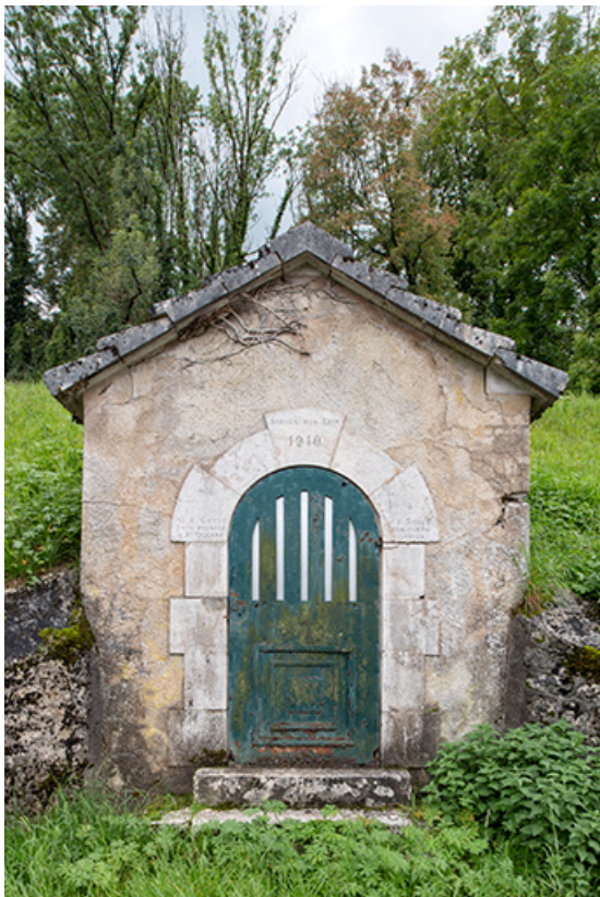
Réservoir de Veley (1910). Façade nord. 39, Salins-les-Bains
