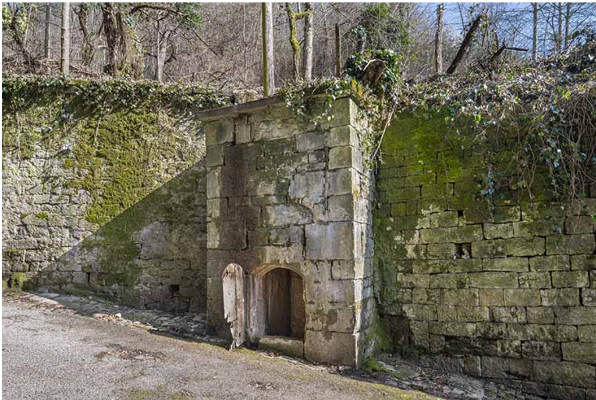
Escalier de Saint-Anatoile. Captage d'une source.
