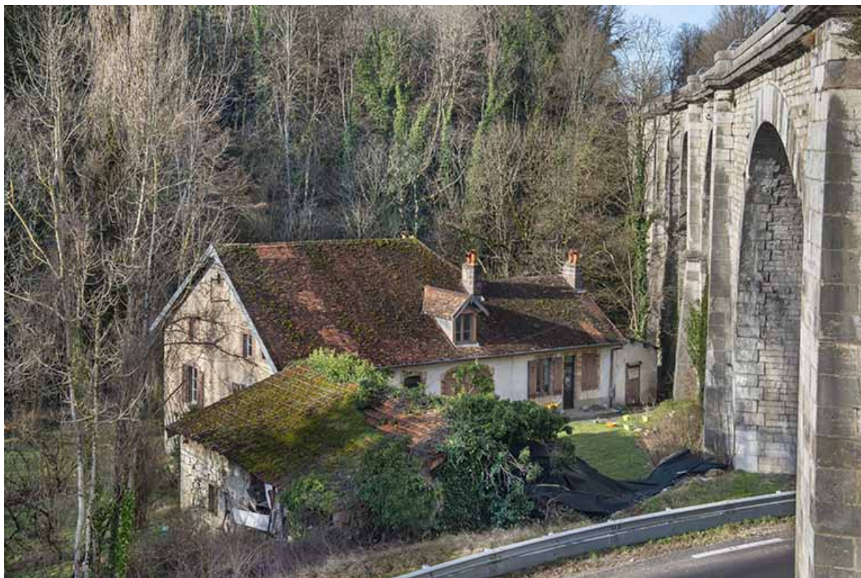
Virage et viaduc, vus de trois quarts.
