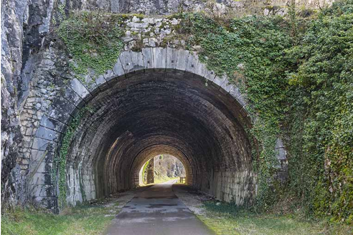
Entrée ouest du tunnel.
