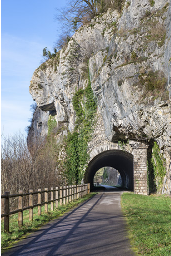
Vue du tunnel depuis l'est.
