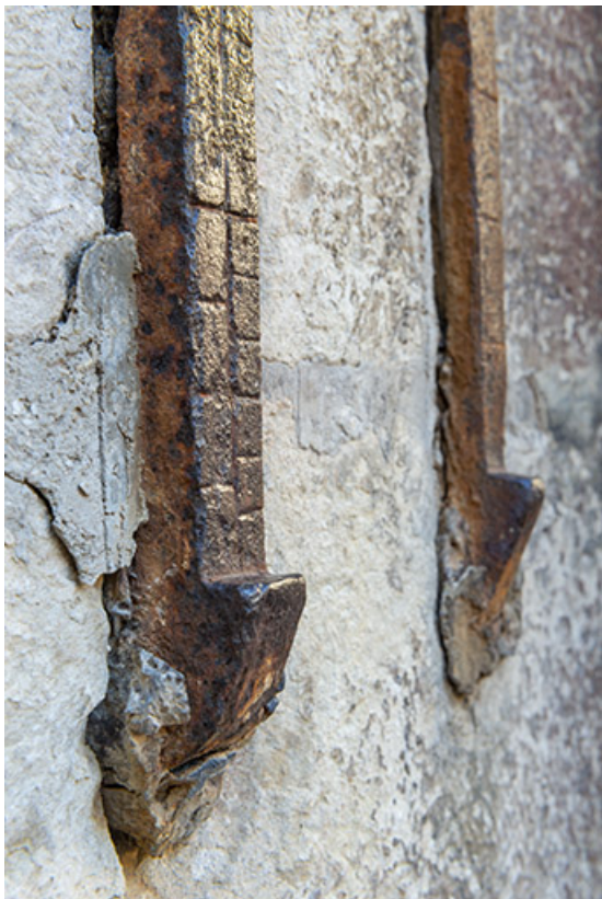
Détail des toises. Graduation double.
