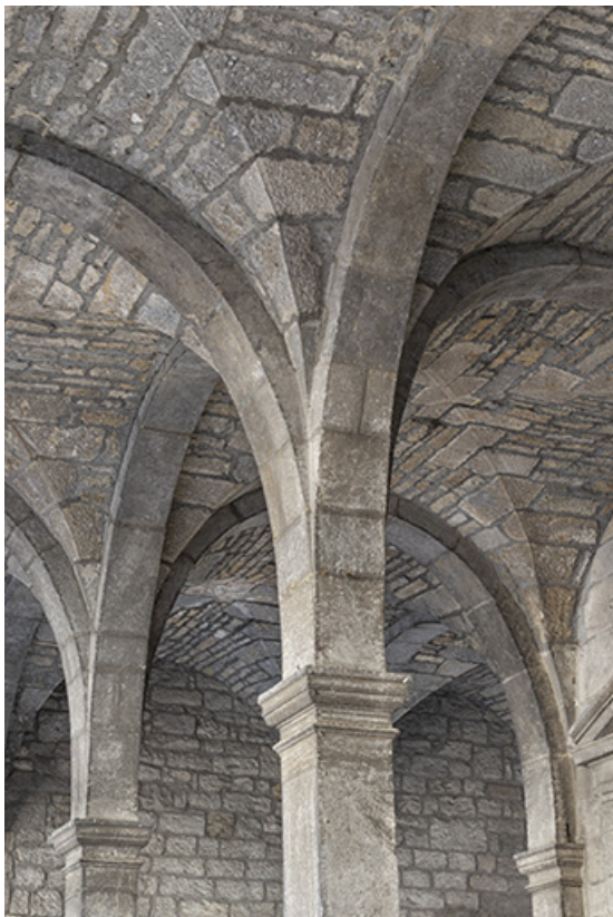
Détail des voûtes d'arêtes.
