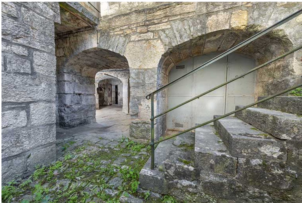
Cour ouest. Accès aux cellules de prison.
