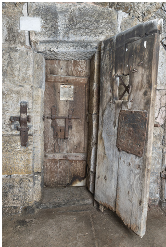
Portes doubles d'une cellule.
