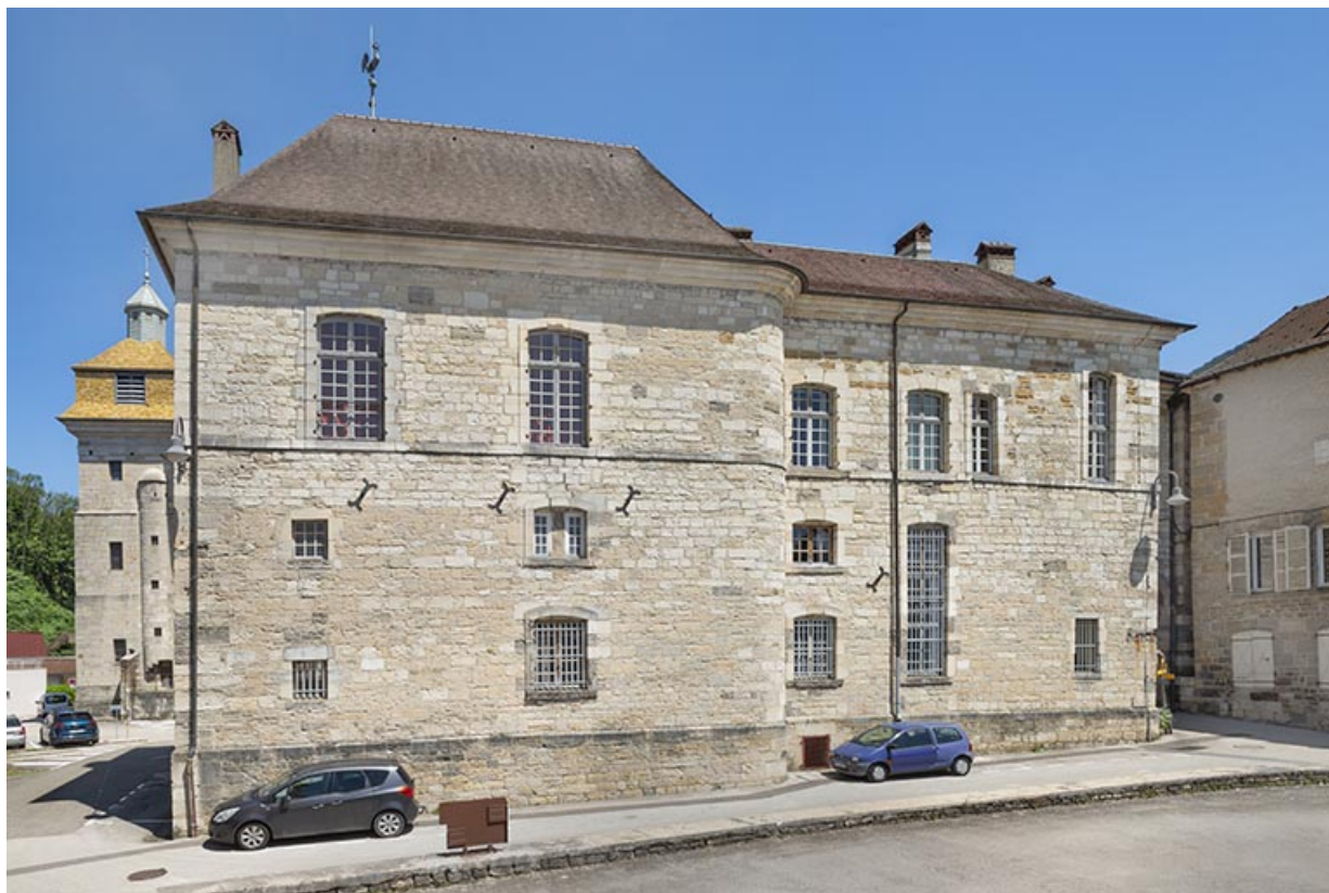
Elévation sud, depuis le sud-ouest.
