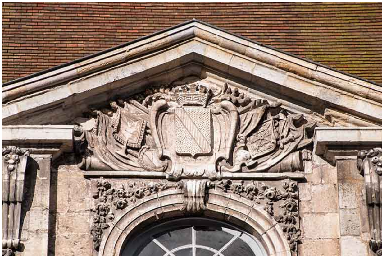
Détail du fronton de la façade est.
