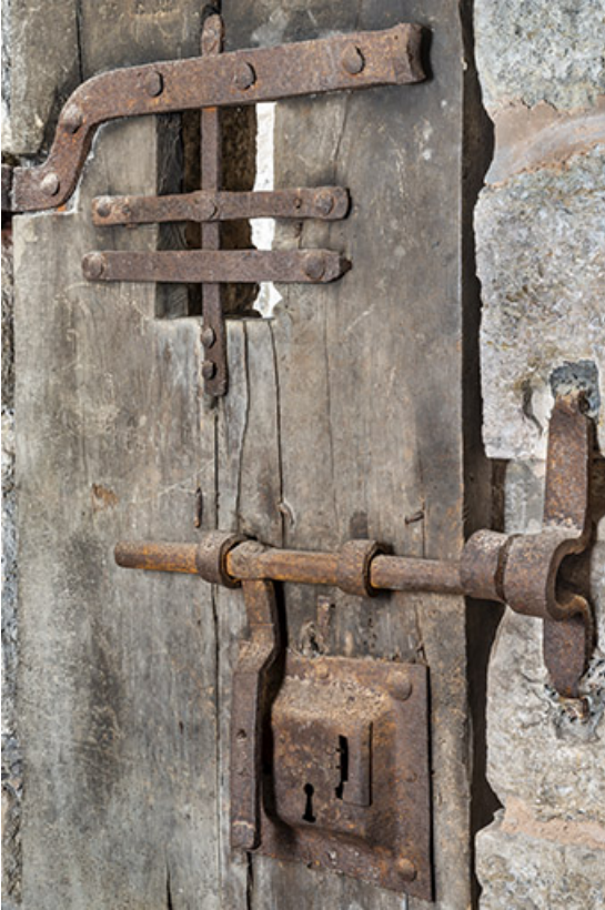
Vue rapprochée d'une porte.
