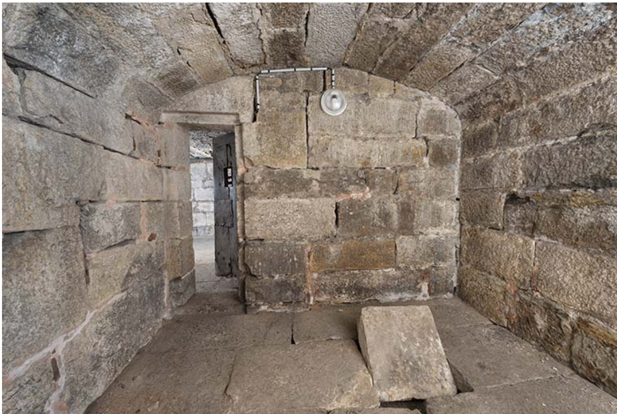
Intérieur d'une cellule.
