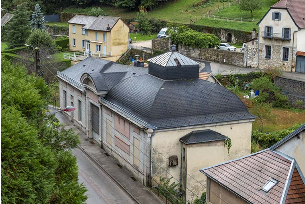
Vue plongeante depuis le nord-est.
